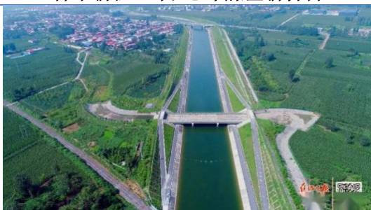
南水北调中线工程
