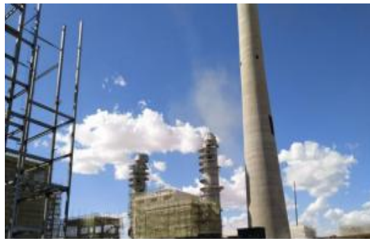
新疆天盈化工锅炉烟气氨法脱硫超净排放
