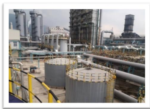
图：印尼金瑞新能源焦炭项目施工现场
