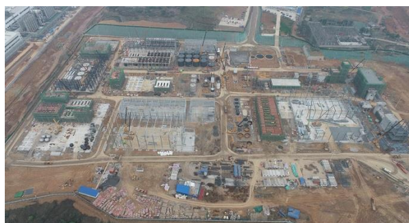
伟能锂电一期年产2.5万吨电池级氢氧化锂项目工地
