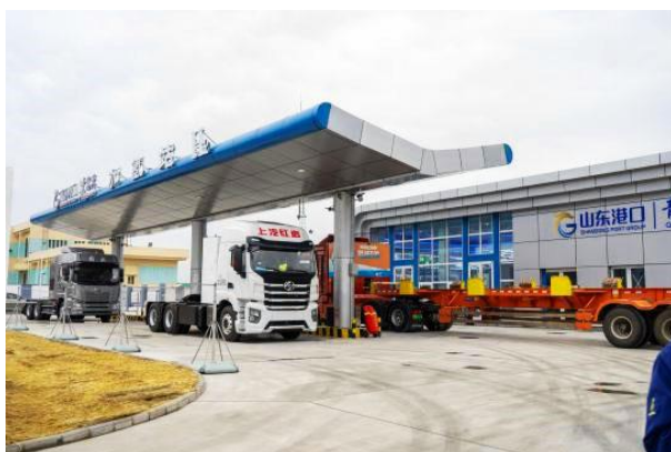
前湾港区加氢站
