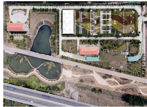
洛阳伊川第二污水处理厂
