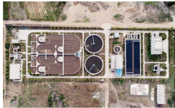
河南首座全埋式地下污水处理厂
