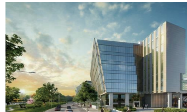
清水源（上海）环保科技有限公司 人才与技术中心
