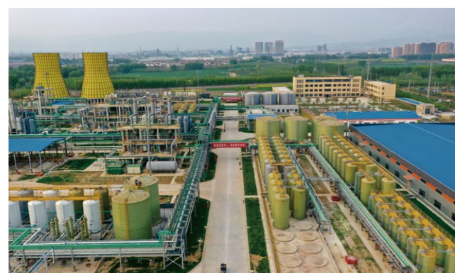
济源市清水源水处理有限公司 水处理剂生产基地
