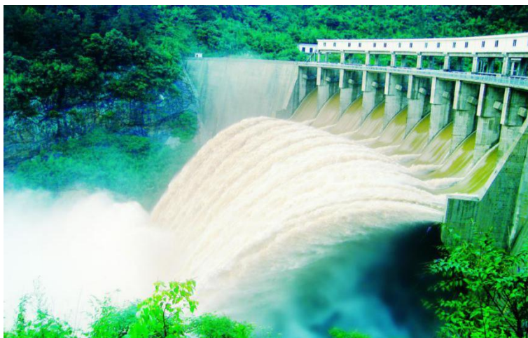
金寨流波崖水电站
