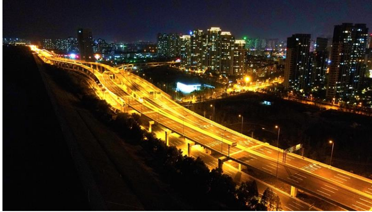
合肥市西二环快速化改造项目
