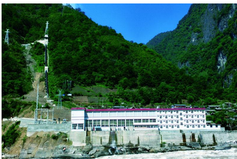
云南怒江丹珠河阶梯水电站
