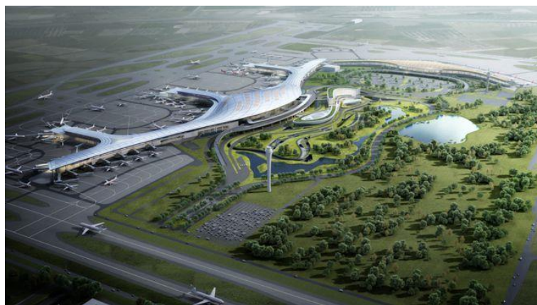
合肥新桥国际机场改扩建工程 T2 航站楼工程
