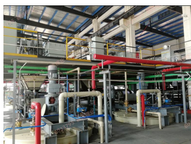
含锂废渣归一化后处理车间
