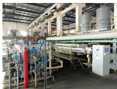
含锂溶液净化除杂车间
