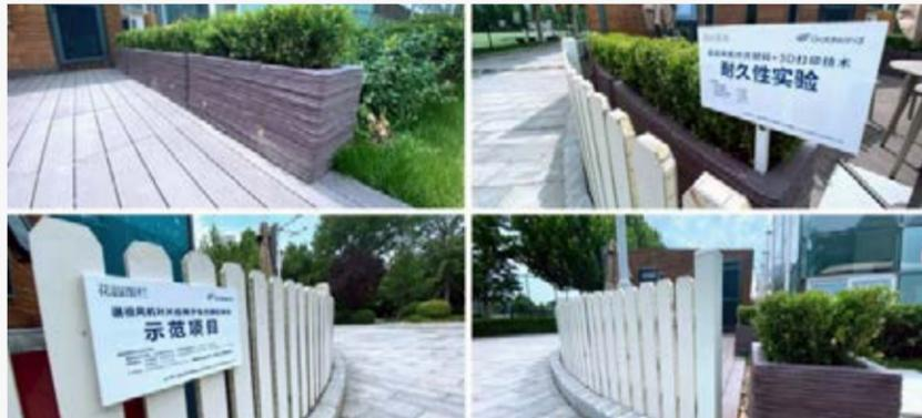
将废旧叶片回收并通过 3D 打印的方式制成花坛
