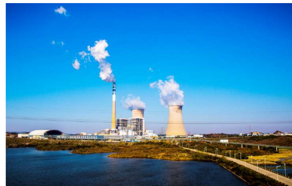
我国首批火电厂脱硫脱硝特许经营项目—江西新昌2X700MW机组脱硫脱硝特许经营项目
