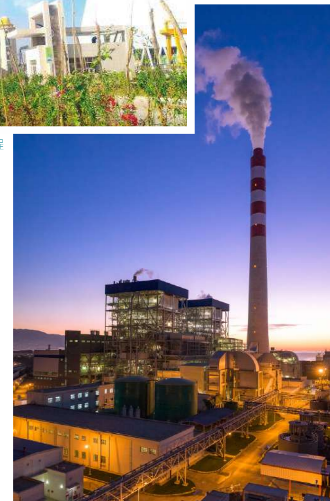
土耳其阿特拉斯发电厂2×600MW机组烟气脱硫工程
