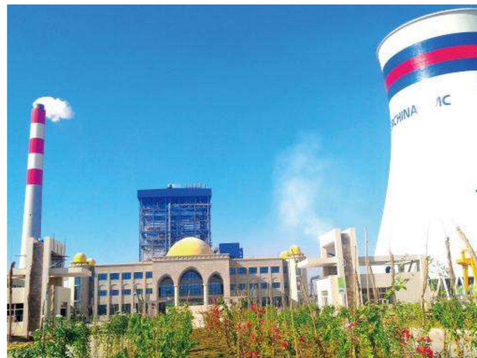
巴基斯坦卡西姆发电厂2×660MW机组烟气脱硫工程
