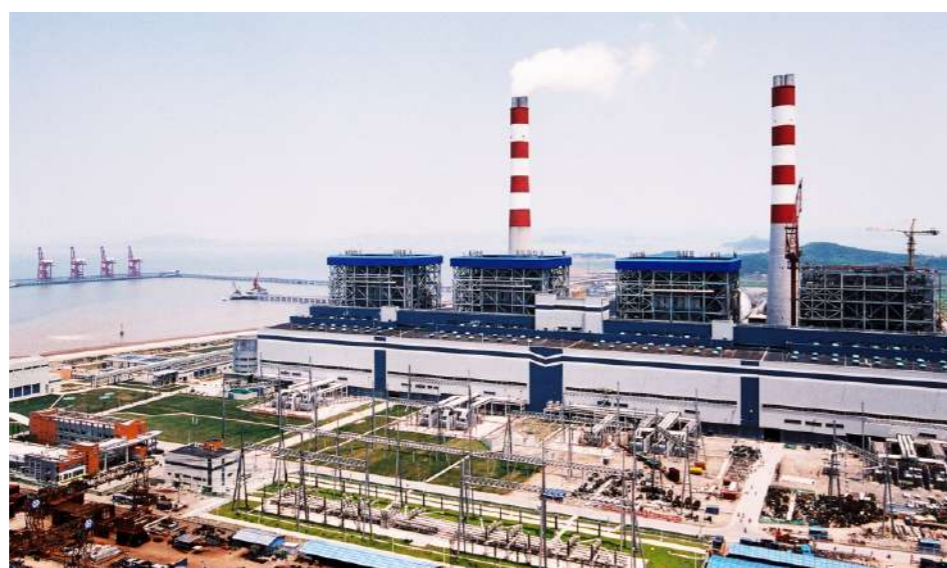
国内首个百万机组脱硫工程—浙江玉环电厂2x1000MW超超临界燃煤机组烟气脱硫工程
