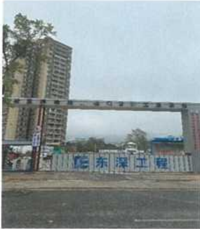
东侧大鹏敬老院在建工程
