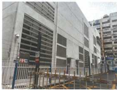
北侧南方电网变电所
