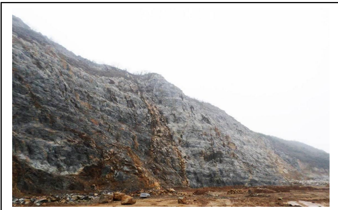
高陡硬质岩石坡面（河南新乡，混凝土坡面）
