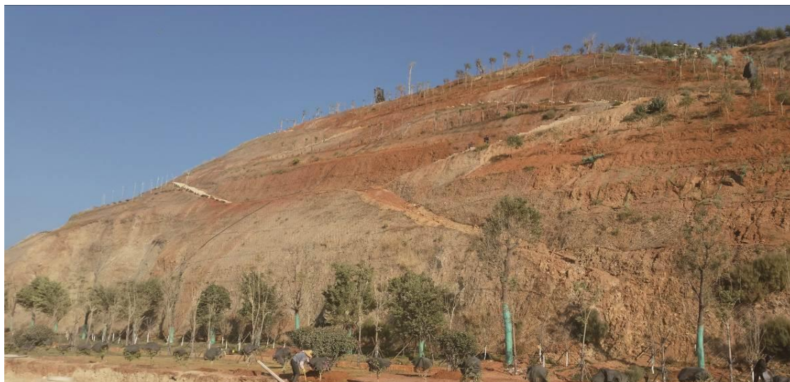
软质岩石矿山（云南大理，粉砂质泥岩、强风化、遇水易崩塌）
