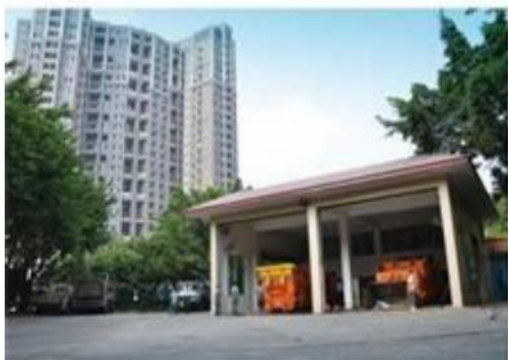
垃圾压缩中转站全貌
