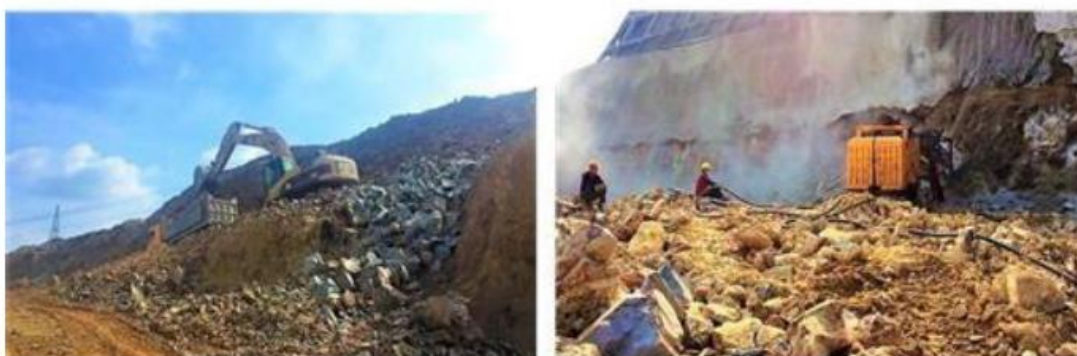
土石方开挖施工
