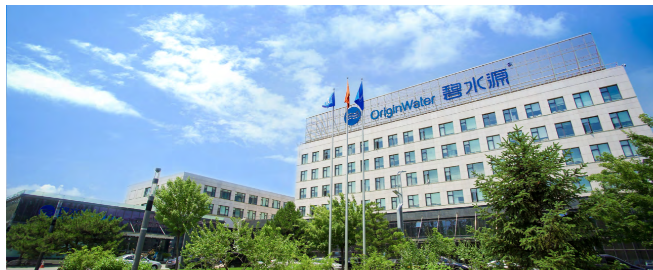
碧水源园区建设
