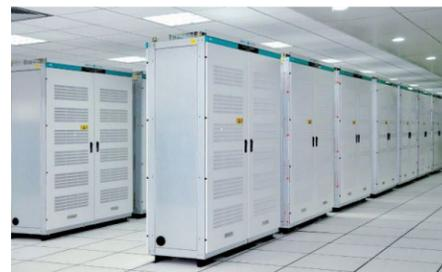
DPS-5000G特高压直流输电控制保护系统
