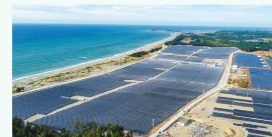
菲律宾库里马奥太阳能发电厂二期项目
