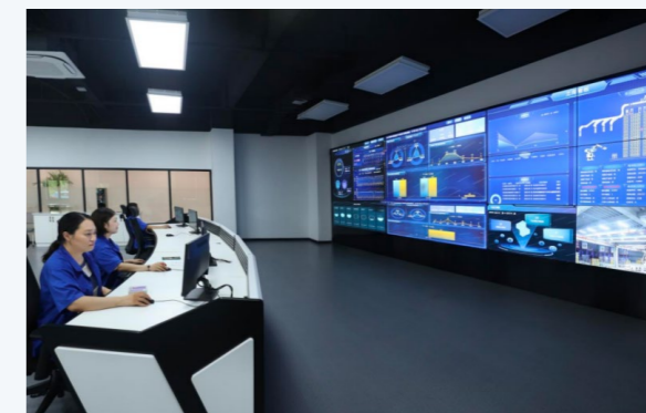
智能科技产业基地中控室
