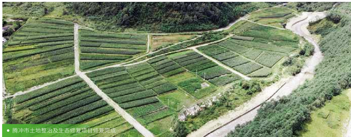
• 腾冲市土地整治及生态修复项目修复中
