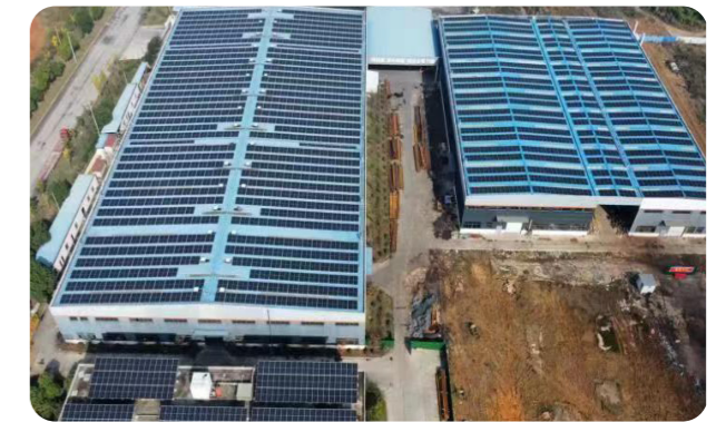
芜湖明特威光伏发电项目
