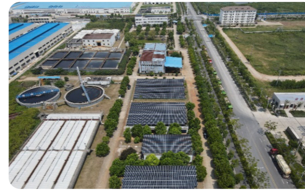
安庆宜源污水处理厂光伏发电项目
