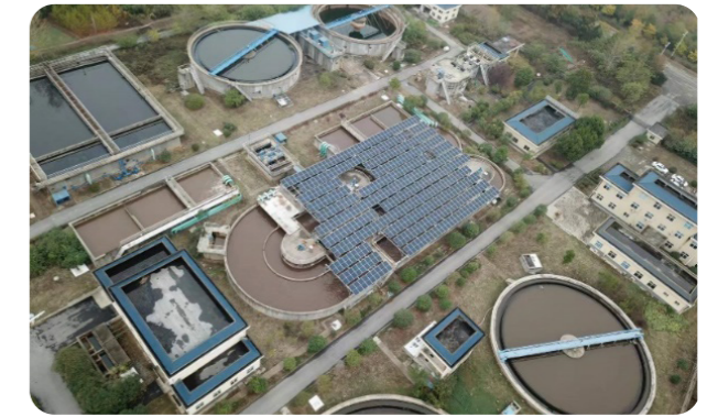
安庆清源污水处理厂光伏发电项目
