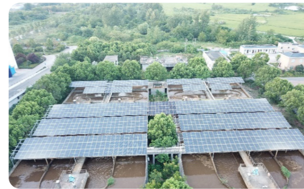
桐城市城南污水处理厂光伏发电项目
