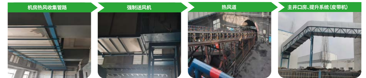
空压机散热风流系统改造工艺示意图
