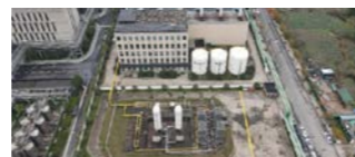
余杭新奥分布式光伏发电系统
