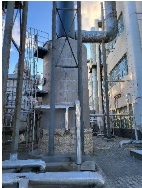
新威远发酵一期更换管束除尘除雾器，开展 风机改造，提高废气处理设施处理效果
