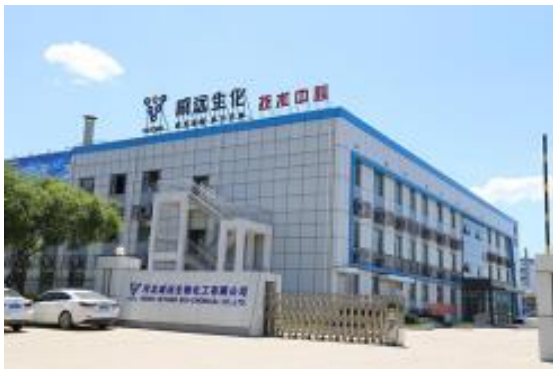
威远生化技术中心
