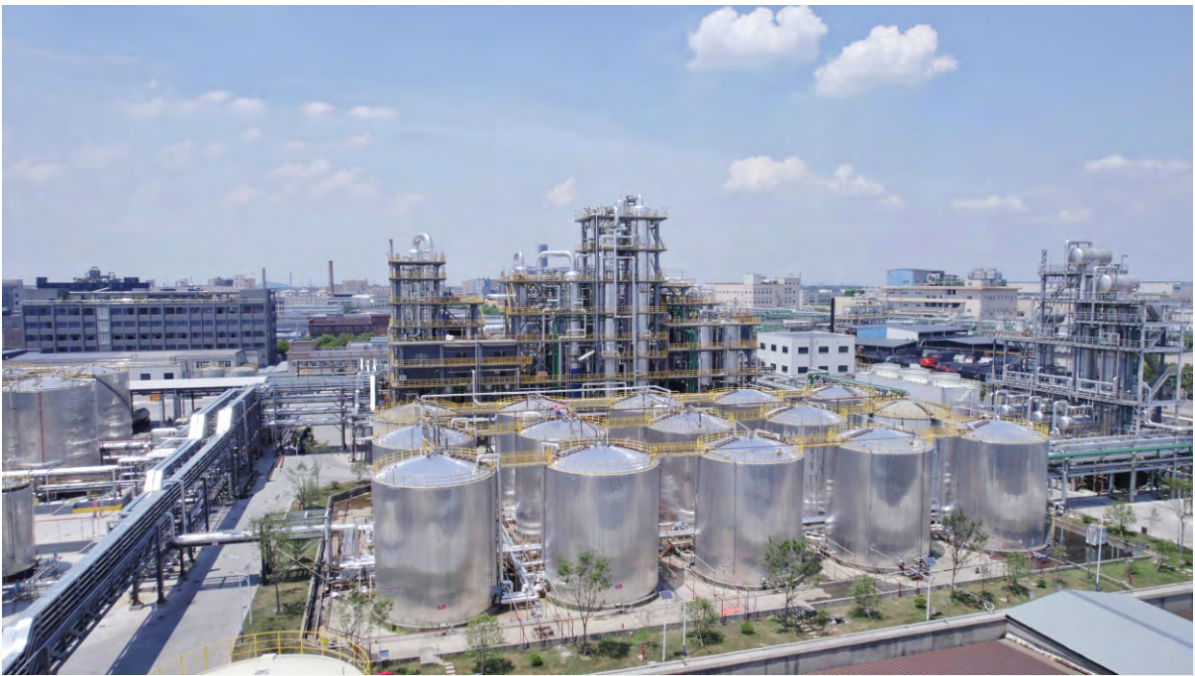
图3-14：产品生产产区俯视图
