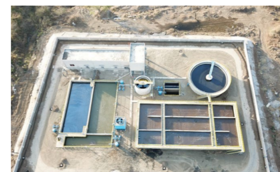
项目现场污水处理站
