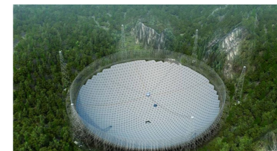
FAST 望远镜全过程咨询和反射板吊装项目
