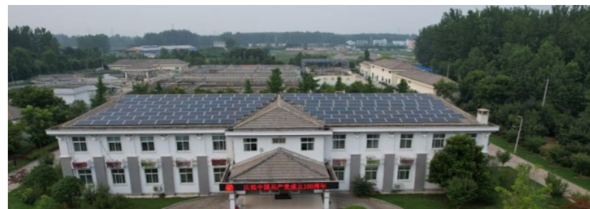
邳州市中工水务有限责任公司安装屋顶光伏系统
