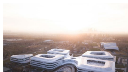
民航运行管理中心和气象中心工程及民航情报管理中心
