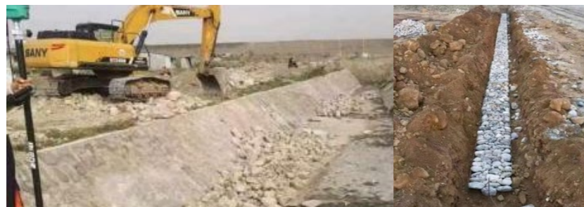
项目现场碎石利用
