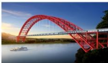
图例：四川犍为岷江大桥
