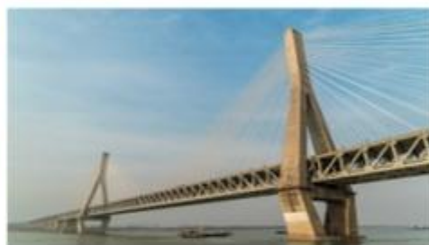
图例：天兴洲长江大桥
