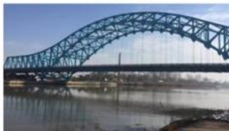
图例：泗阳城子河公路大桥
