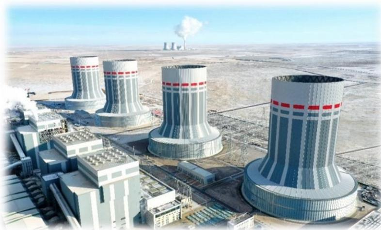
图 2：国电上海庙双维电厂全钢结构空冷塔
