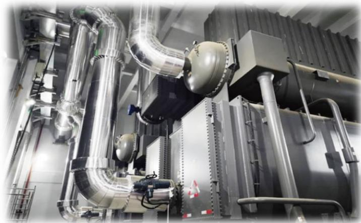
图 1：溴化锂冷热机组
