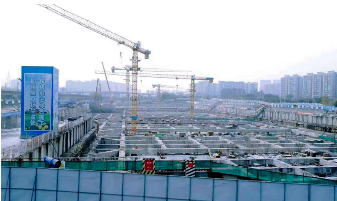
“成都市绿色标杆工地”——凤凰河二沟再生水工程项目
