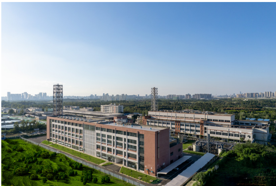
成都市第一城市污水污泥处理厂
