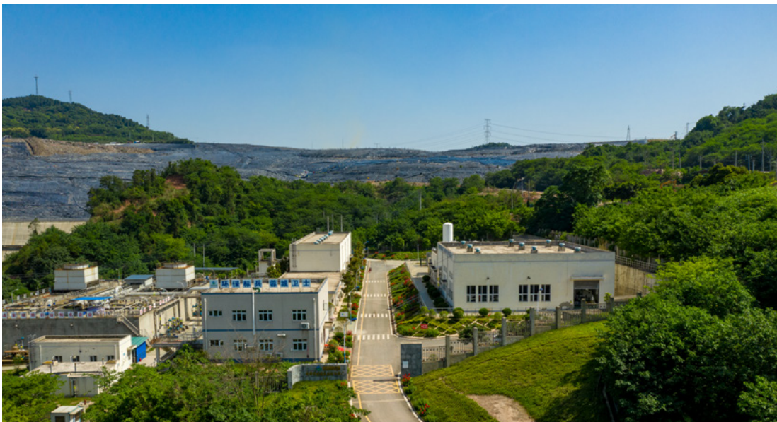
再生能源公司垃圾渗滤液厂 (二期)
