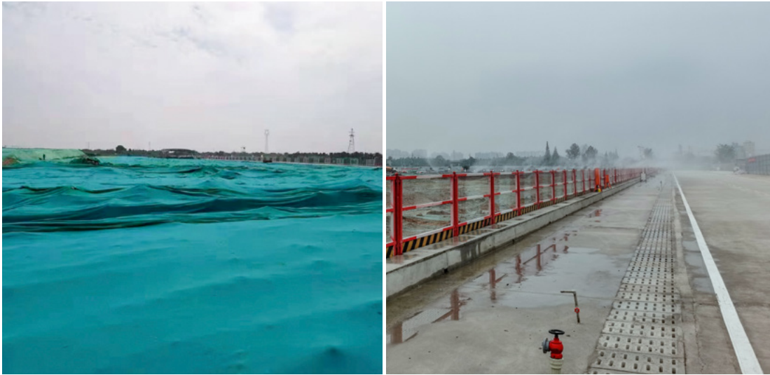
通过裸土覆盖、湿法作业减少施工环节的环境影响
