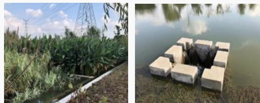
邵家桥水系净化工程现场实拍图
