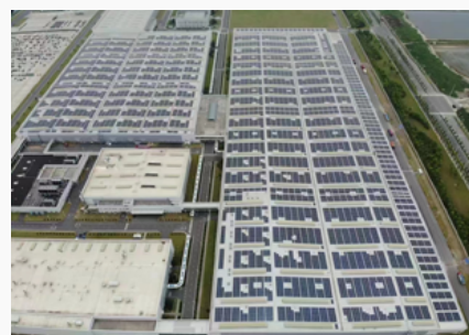
余姚领克汽车基地 21MW
