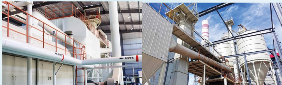
大唐三門峽建築石膏粉生產線實景圖
