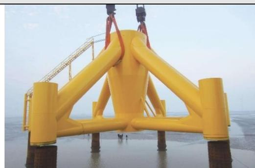
公司生产的导管架是海上风电设备的组合式支撑基础，由上部钢制桁架与下部多桩组配而成，上端与风电塔筒相连、下端嵌入海床地基中，起到连接和支撑作用，适用于复杂地质地貌的海洋环境。
