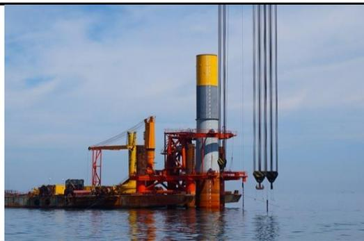
公司生产的桩基是海上风电设备的支撑基础，其上端与风电塔筒连接，下端深入数十米深的海床地基中，用以支撑和固定海上的风电塔筒以及风电机组，其对海底地质和水文条件要求较高。
