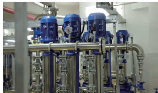
推动远洋万象小区二次供水设施改造
