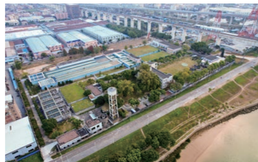
启动东风水厂三期扩建工程，供水能力将达到20万立方米/天
