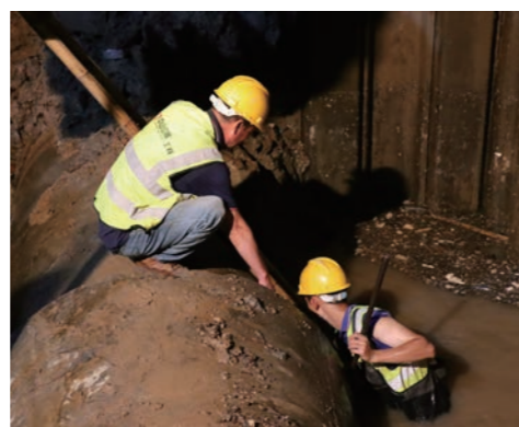
公用工程中秋节连夜奋战水管抢修，保障民生供水
