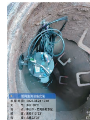
分布式液位水质仪安装
