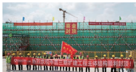
中嘉污水厂三期扩建工程主体结构全面完成封顶
