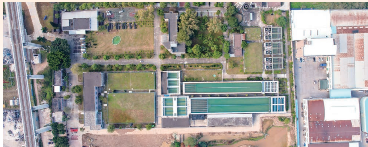
水务公司启动东凤水厂三期扩建工程
