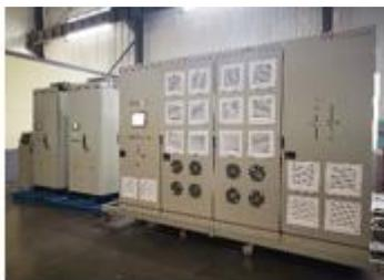
储能型再生制动能量利用装置
