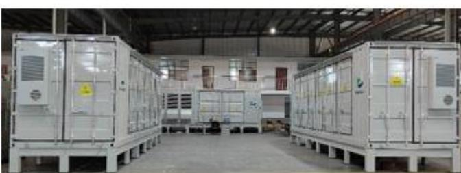
牵引供电再生制动能量利用及储能装置
