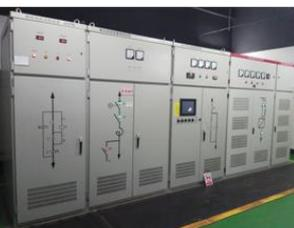
逆变+电阻混合型再生制动能量吸收装置
