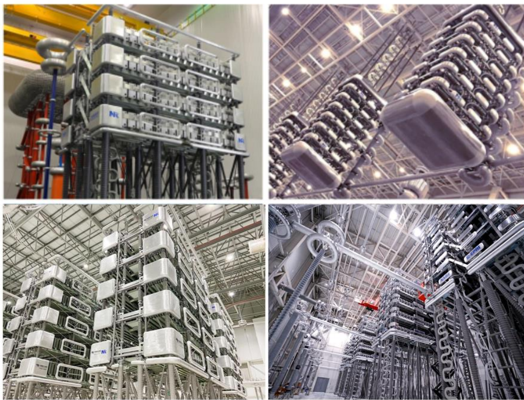
(柔性输电项目换流阀工程图)
