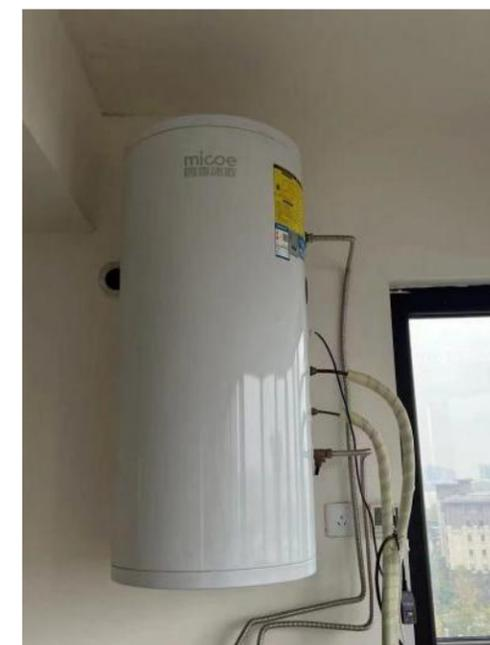
由于空气能热水器的工作是通过介质换热，因此其不需要电加热元件与水直接接触，避免了电热水器漏电的危险，也防止了燃气热水器有可能爆炸和中毒的危险，更有效控制了燃气热水器排放废气造成的空气污染
