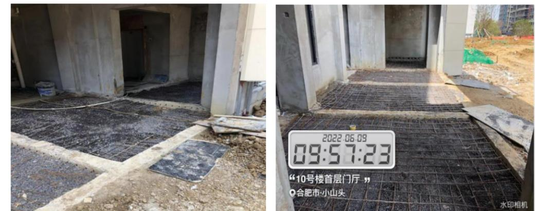
浙皖公司严格执行集团质量管理体系，始终将工程质量摆在首要位置。肥西湖樾花园狠抓质量红线，其中首层地面下存在房心回填土，严格要求先将板下回填土夯实，再进行楼板施工，防止沉降
