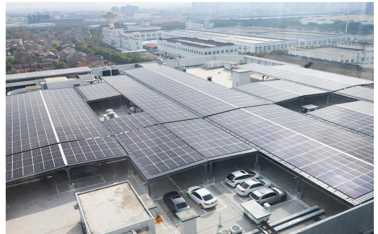
该光伏项目采用“自发自用，余电上网”的并网方式，发电设施计划总装机容量为0.91兆瓦，项目实施完成后，预计可实现公司绿色用能、低碳发展。此外公司采用电动叉车代替柴油叉车、新能源汽车替代传统汽油车等，改变能源结构，提高可再生资源利用率，降低了企业的整体能耗水平，减少碳排放。企业生产向着低碳化、绿色化、高效化方向稳步前进，为建设浙江省和宁波市绿色制造体系贡献了自己的一份力量。
