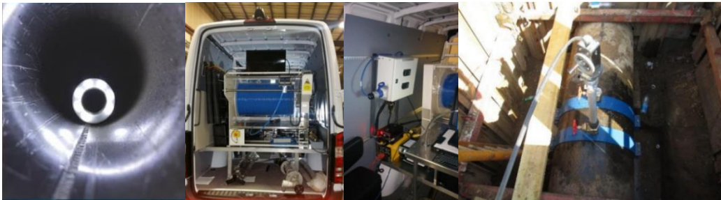
管道探测工程案例
