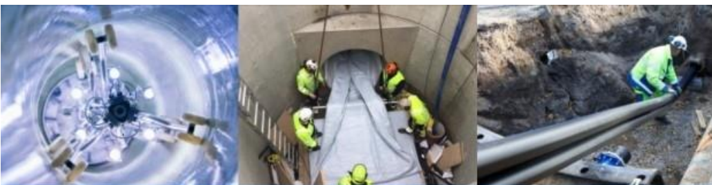
非开挖修复工程案例
