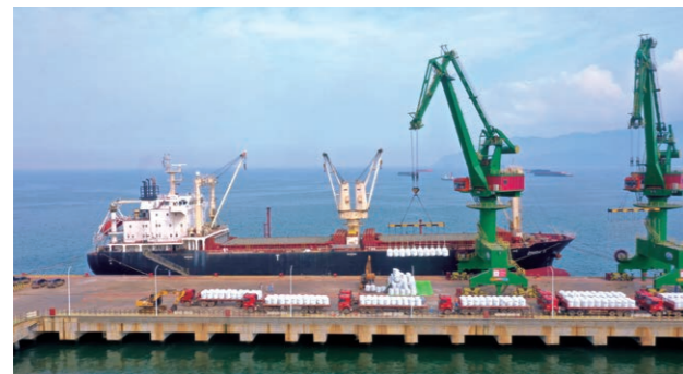
青美邦镍资源项目MHP装船现场
