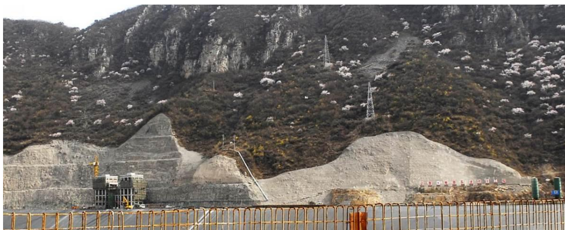
软质岩石矿山（云南大理，粉砂质泥岩、强风化、遇水易崩塌）
