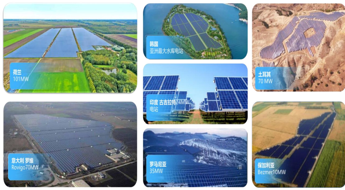
图 8：正泰新能源海外光伏项目
