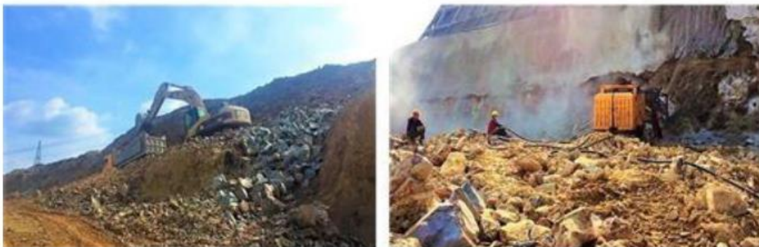
土石方开挖施工
