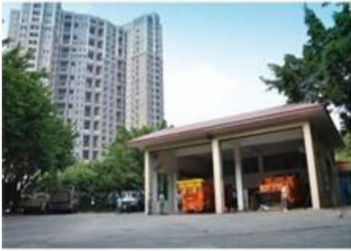
垃圾压缩中转站全貌
