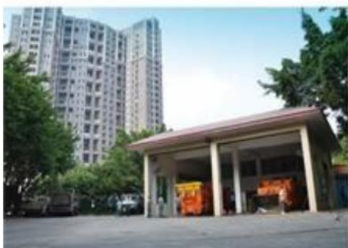
垃圾压缩中转站全貌
