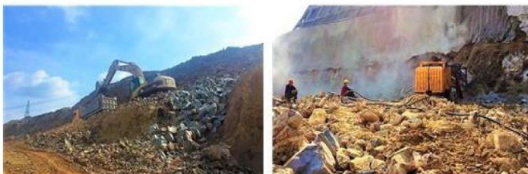
土石方开挖施工
