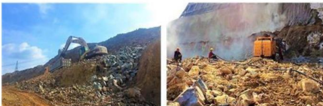
土石方开挖施工
