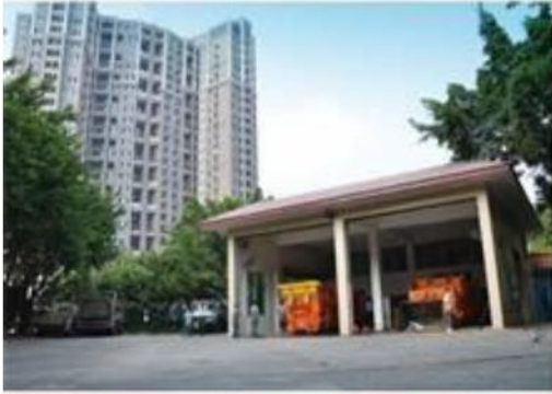
垃圾压缩中转站全貌
