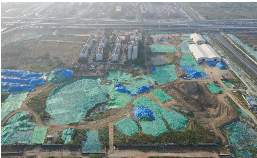
氯碱化工污染治理一期东二东三地块
