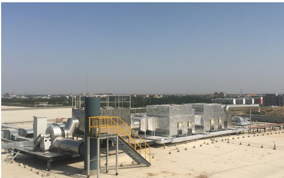
衡水以岭药业前处理车间和制剂车间末端废气处理工程
