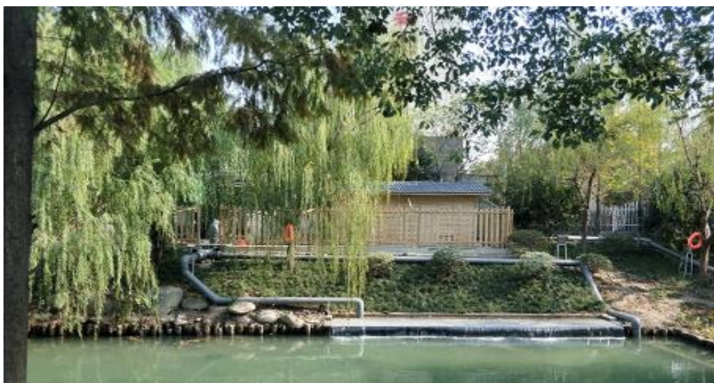
杭州市拱墅区褚家河智慧配水净化工程
