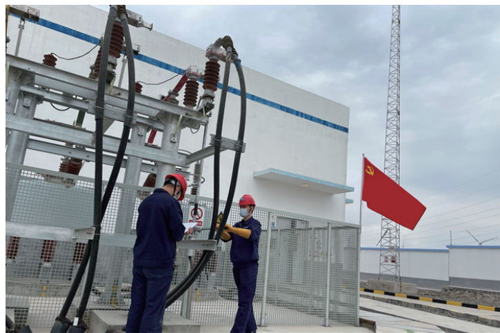
新疆分公司五家渠片区设备检修及消缺
