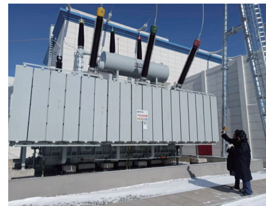
电场运行团队对风电场内场区设备进行全面巡检
