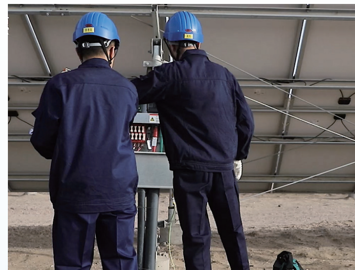
青海分公司格尔木检修中心汇流箱维护保养
