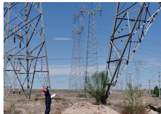
宁夏分公司检修中心对线路进行全面巡检
