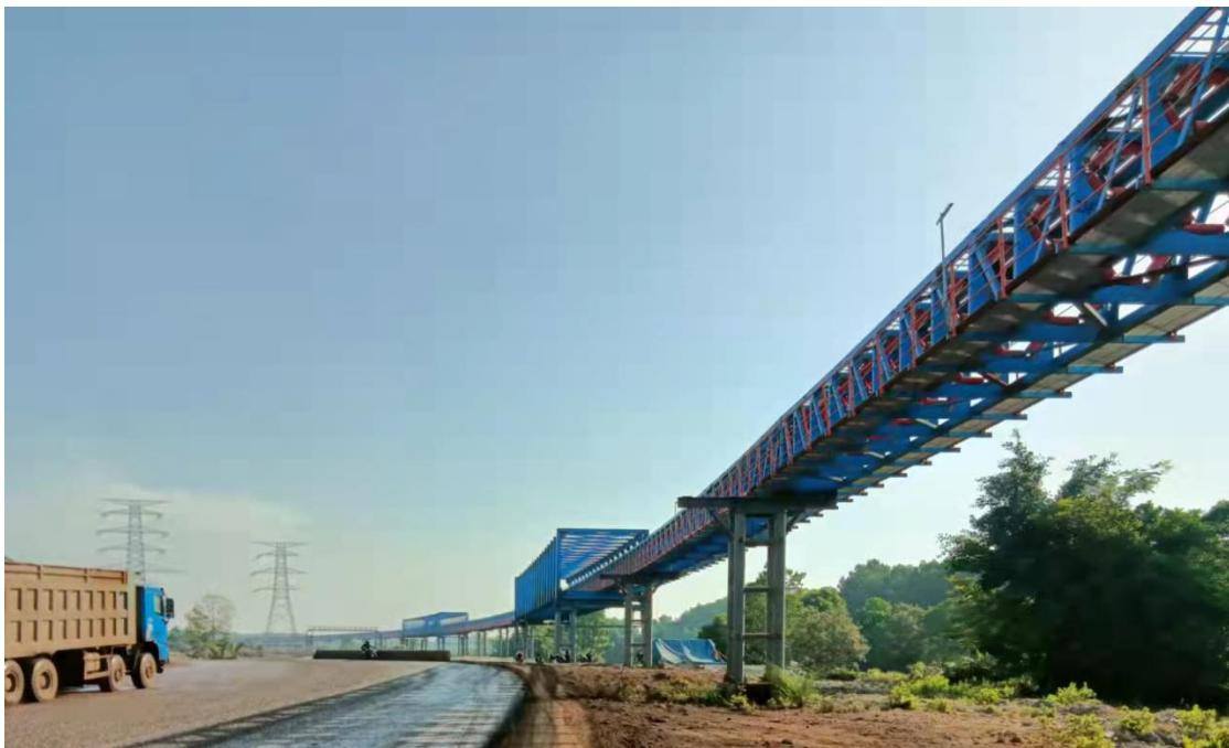
注：印尼德龙 DG550 长距离管状带式输送机项目。
