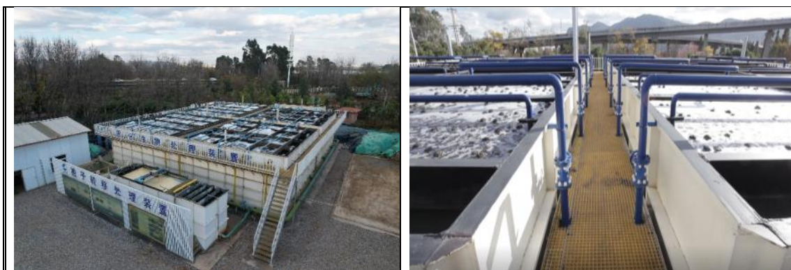
昆明市西山区车家壁岔沟水质改善工程（现场实景）
