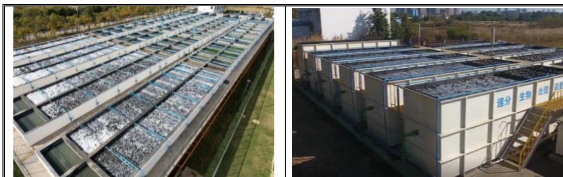
速分生物处理系统实景图
