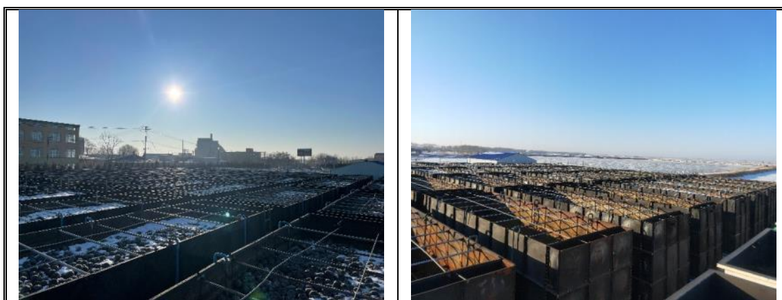
齐齐哈尔市昂昂溪纳污坑塘综合治理项目（现场实景）
