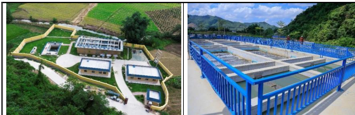
广西崇左市天等县龙茗镇乡镇污水处理厂项目 (现场实景)
