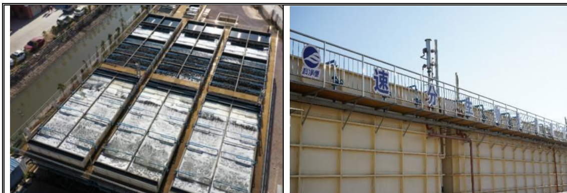
昆明市官渡区老海河水质提升工程（现场实景）
