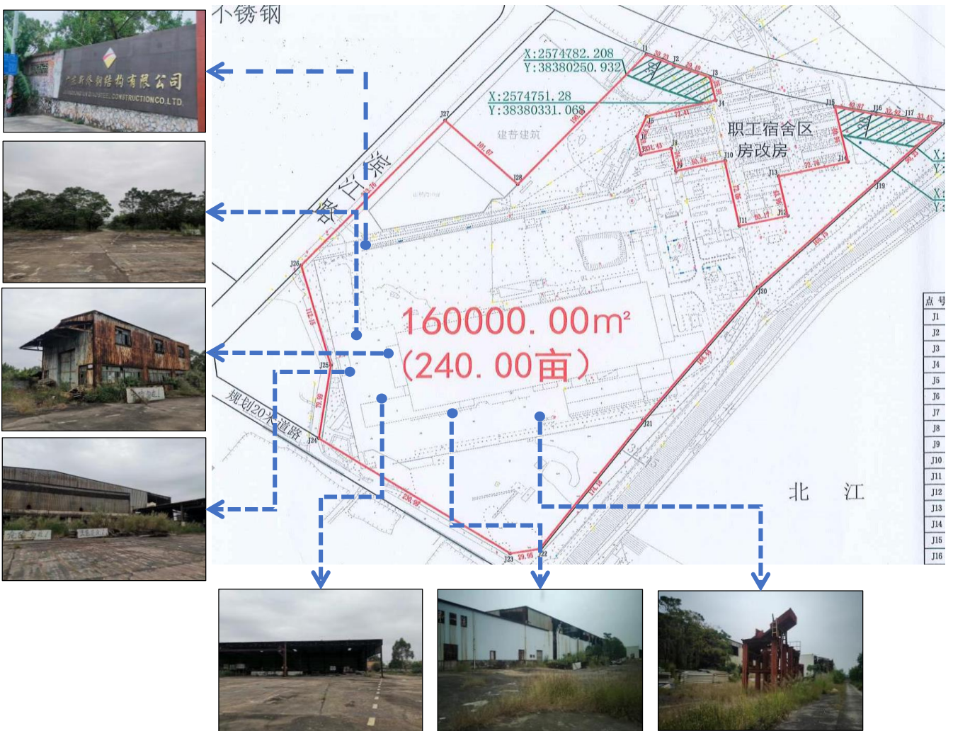
图 4-2 项目场地内（入口钢结构厂房）现状图 1
