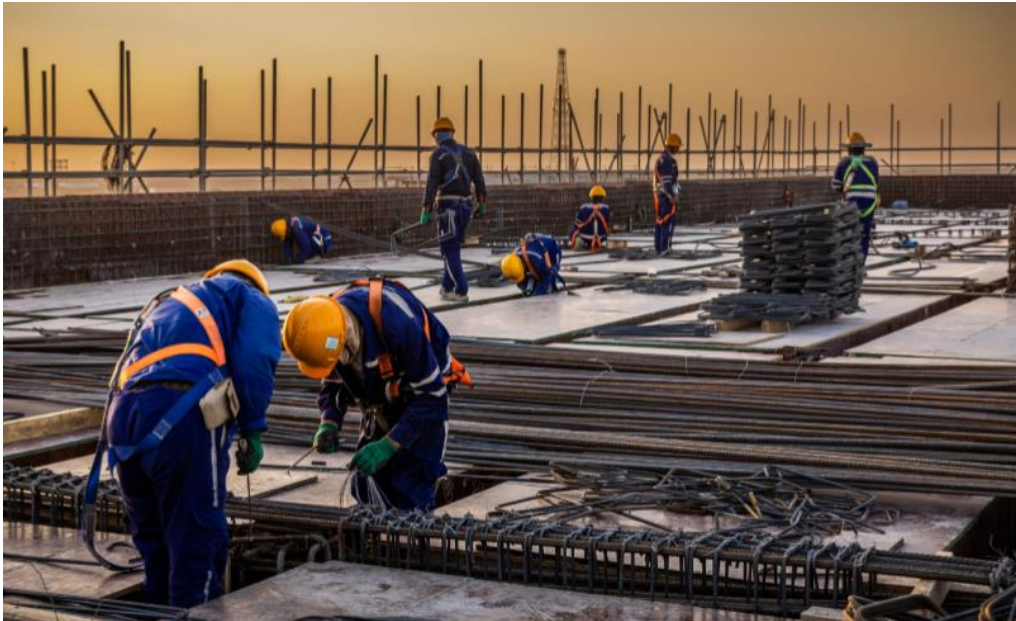
注：伊拉克九区原油中央处理设施项目施工现场图
