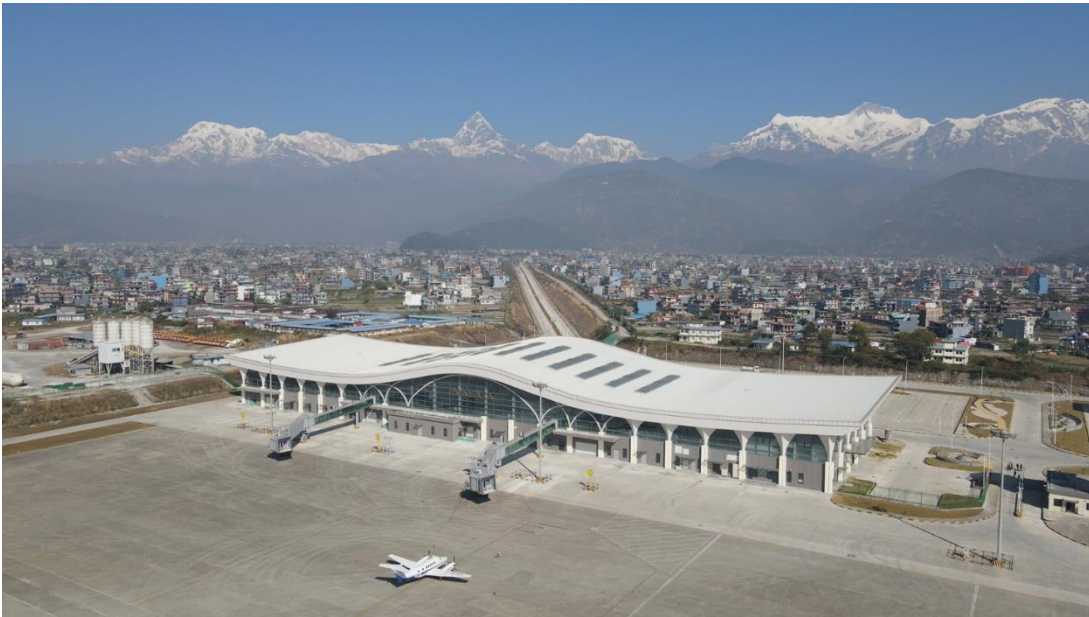
注：公司承建的尼泊尔博克拉国际机场项目
