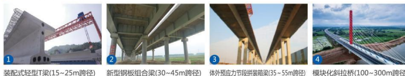
1 装配式轻型T梁(15~25m跨径) 2 新型钢板组合梁(30~45m跨径) 3 体外预应力节段拼装箱梁(35~55m跨径) 4 模块化斜拉桥(100~300m跨径)
