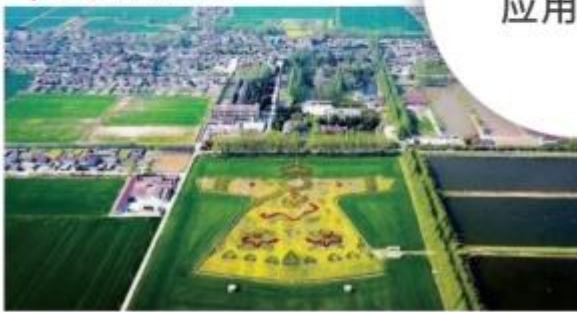
| 中铁六合龙袍新城项目
