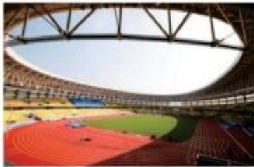
| 武汉东西湖五环体育馆预制清水看台板项目
