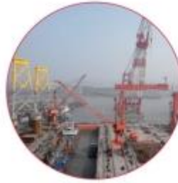
| 江苏海新船务重工有限公司轨道安装项目
