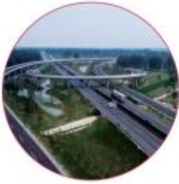
| 阜源高速公路建湖至兴化段
