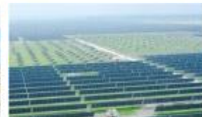
国家光伏·储能实证实验平台(大庆基地)一期工程项目
