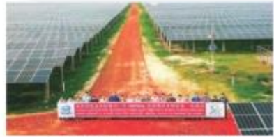
▲ 孟加拉国迈门辛市50MWac光伏项目
