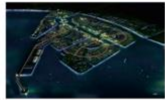
山东裕龙石化项目
