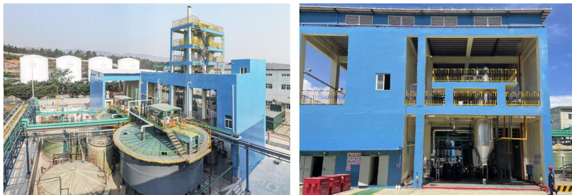
云锡铜冶炼污水废水深度处理项目
